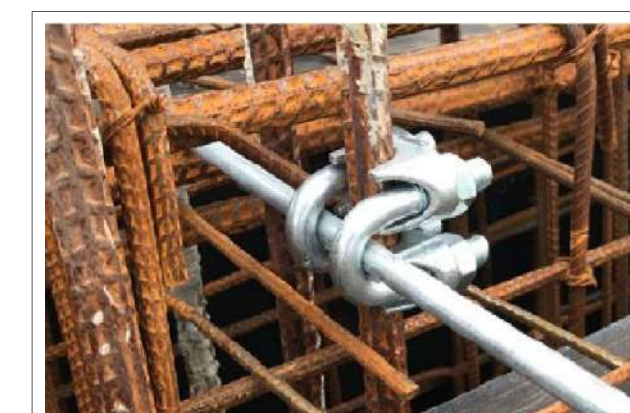
03. Detalhe da Conexão Aterramento
