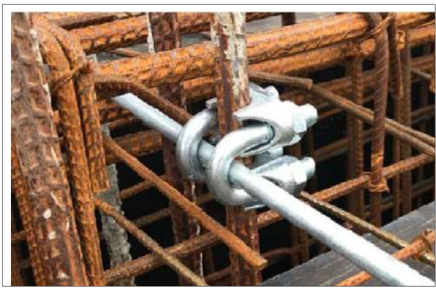
03 Detalhe da Conexão Aterramento QGBT
